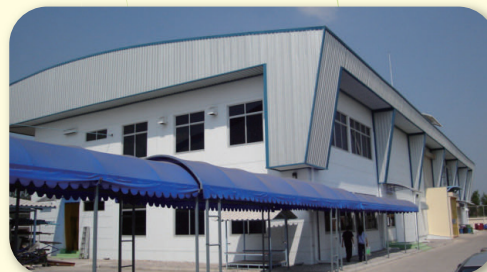
ASAHI INTECC (THAILAND) CO.,LTD. タイ第4工場
